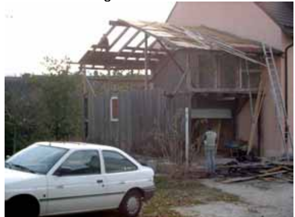
alter baufälliger Schuppen am Dorfteich
