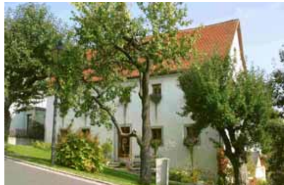
Frackdachhaus Rauh/Jena den geschützten Friedhof,
