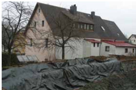
Einbau der Folie in den Damm
