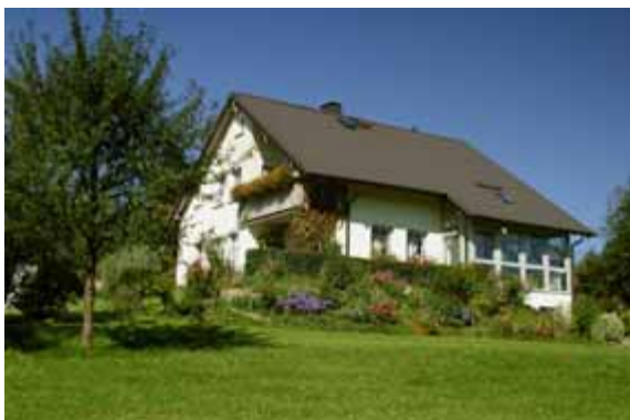
Ortsrandbebauung altes Dorf Fam.Petzoldt
