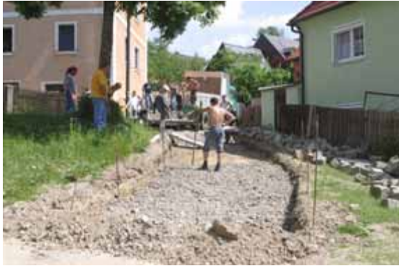
Pflasterung an der Schwemm mit Großpflaster 2006
