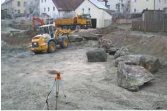
Einbau der Felsen auf die Wasserlinie
