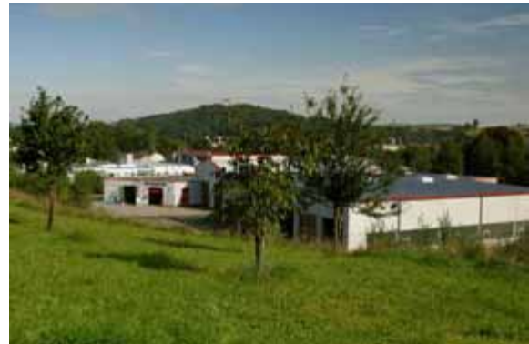
Waschpark, Fuhrunternehmen und Tankstelle Panzer
